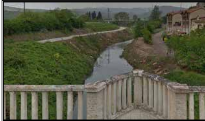
Fotografía de la zona aguas arriba del puente, donde ha sido extraída toda la vegetación arbórea existente.
